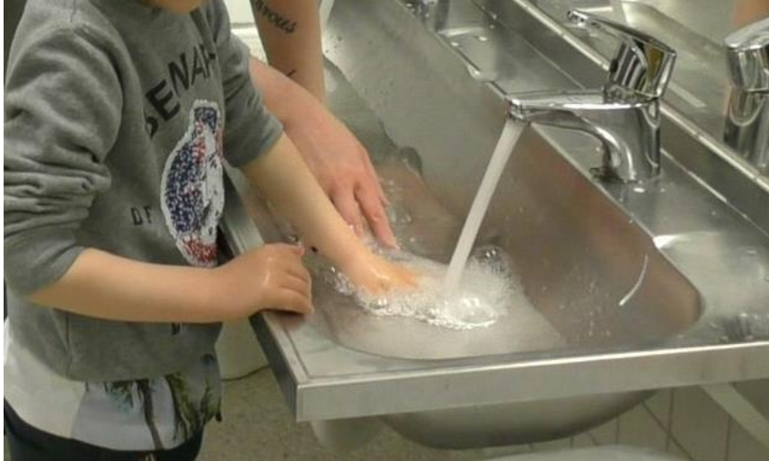
Barn leker og plasker med hendene i vasken. Det er to blandedbatteri på vasken slik at flere barn kan stå sammen.
